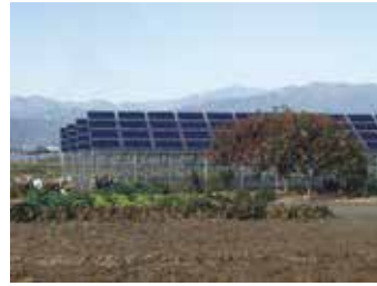
【たくやま太陽光発電所】
