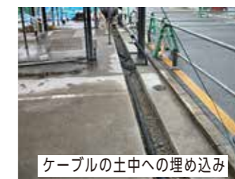
ケーブルの埋め込み部分を復元
