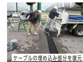
ケーブルの土中への埋め込み
