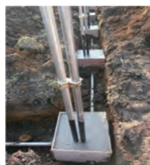
キャストイン工法 基礎部分
