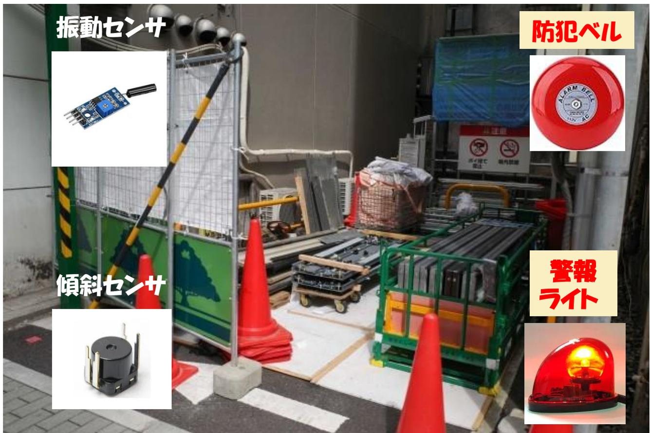
盗難されそうな物品の環境変化（振動、傾斜等）を各種センサで収集します。そのセンシングデータが**異常と検知**した瞬間に防犯ベル、警報ライトを動作させて**威嚇**します。
